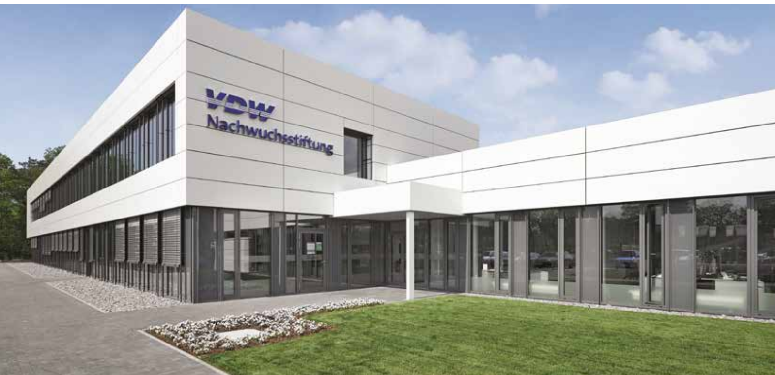
Das neue Bürogebäude der VDW-Nachwuchsstiftung in Bielefeld
